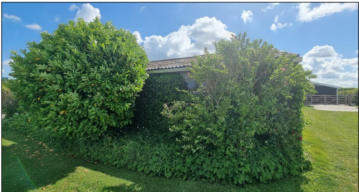
Foto 3: Begroeide zijgevel van het centrumgebouw.
