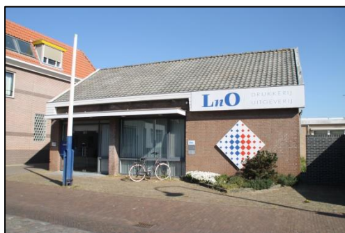
De zuidzijde van het te slopen gebouw.
