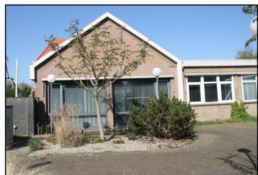
De oostzijde van het te slopen gebouw.
