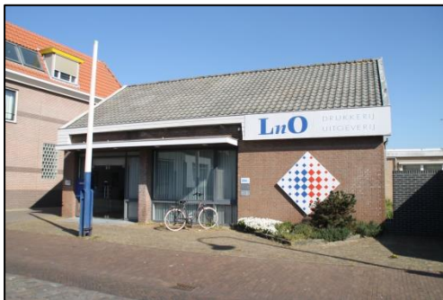
De zuidzijde van het te slopen gebouw.
