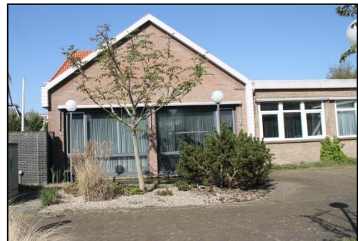
De oostzijde van het te slopen gebouw.
