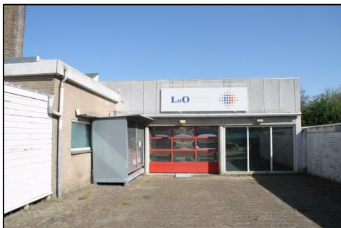
De noordoostzijde van het te slopen gebouw.
