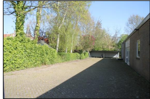
Een fietsenhok ten noordwestzijde van het te slopen gebouw.
