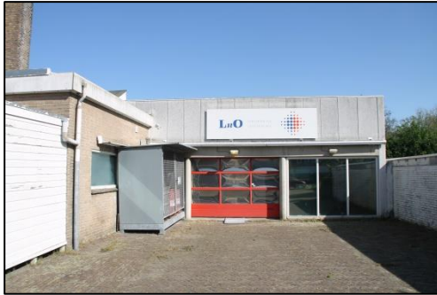
De noordoostzijde van het te slopen gebouw.
