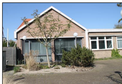
De oostzijde van het te slopen gebouw.
