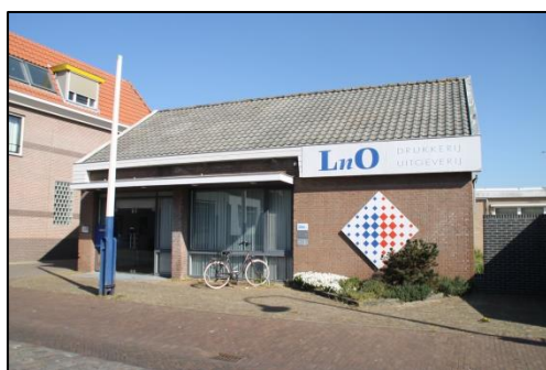
De zuidzijde van het te slopen gebouw.
