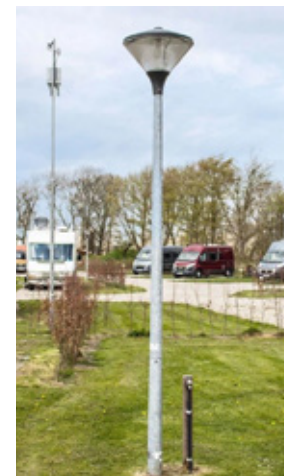
Afbeelding 16: Geplaatste lamp (Gegalvaniseerd stalen lichtmast armatuur type IK-25)
