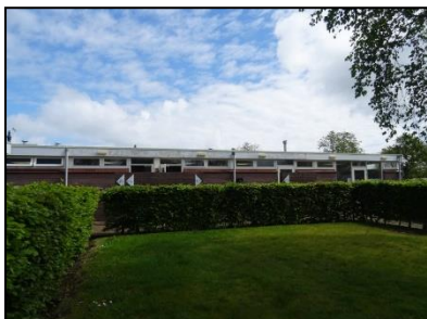
Figuur 12. Kampeerplaats met daarachter de zuidwestelijke gevel van het toiletgebouw.
