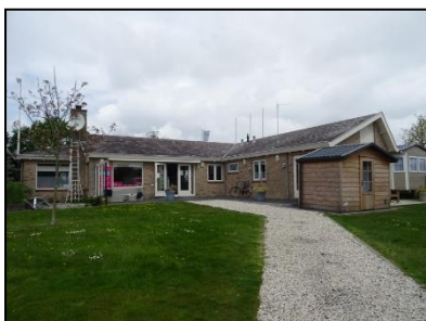
Figuur 9. Overzichtsfoto van de achterzijde van het receptiegebouw.
