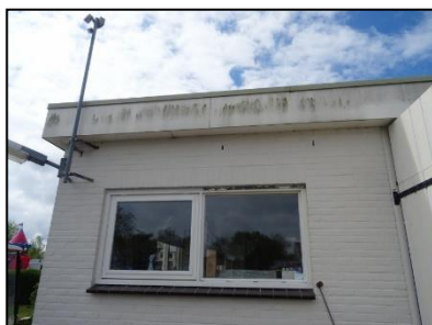
Figuur 10. Noordoostelijke gevel van de werkschuur met bovenaan de gevel open stootvoegen.
