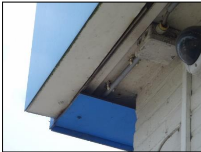
Figuur 22. Opening in de daklijst van de winkel.
