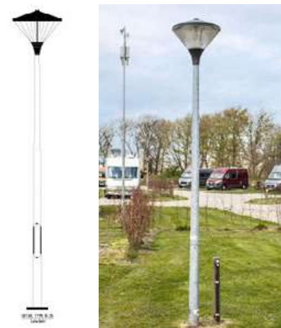
Afbeelding 16: Geplaatste lamp (Gegalvaniseerd stalen lichtmast armatuur type IK-25)
