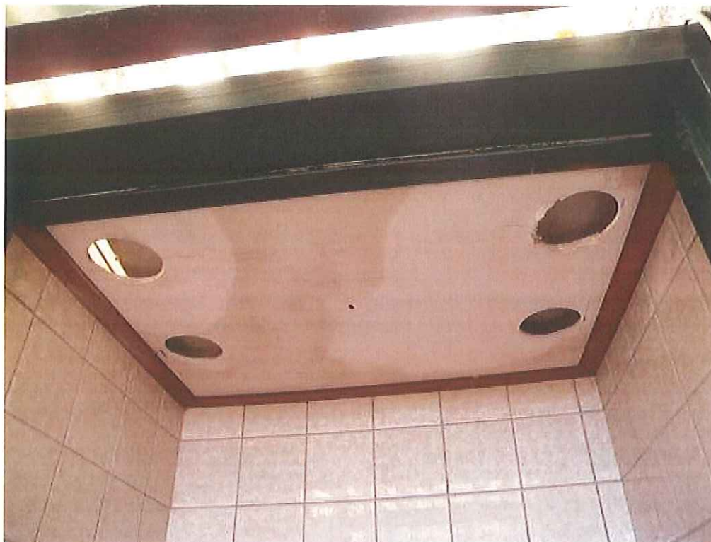
Foto 3 Niet asbesthoudende plafondplaten onderzijde cv-ruimte toiletgebouw 2 (M03)
