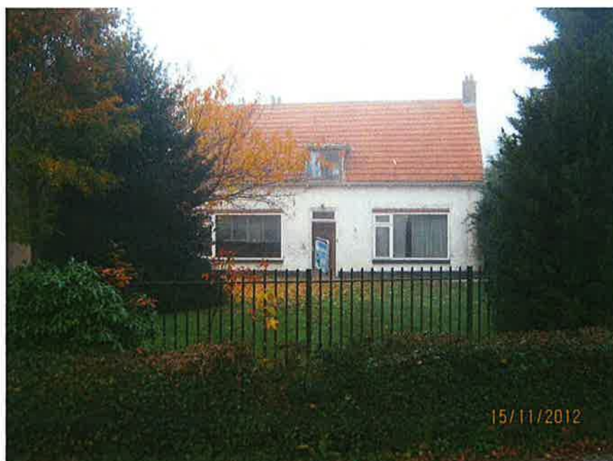
Foto 105. De woning Hogezoom 109 gezien vanaf de weg.
