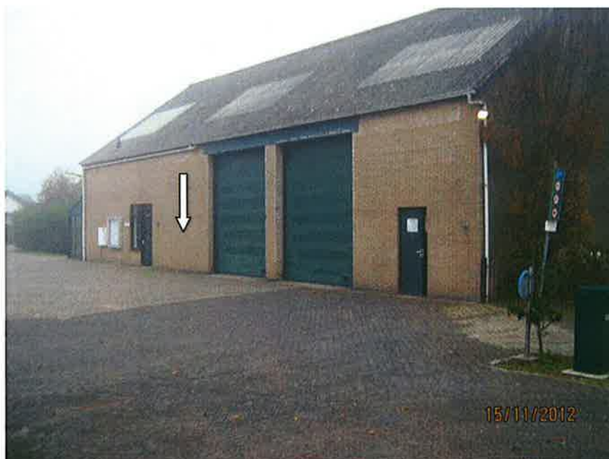
Foto 107. De schuur Hogezoom 111. Bij de pijl bevindt zich binnen een dieselolietank.
