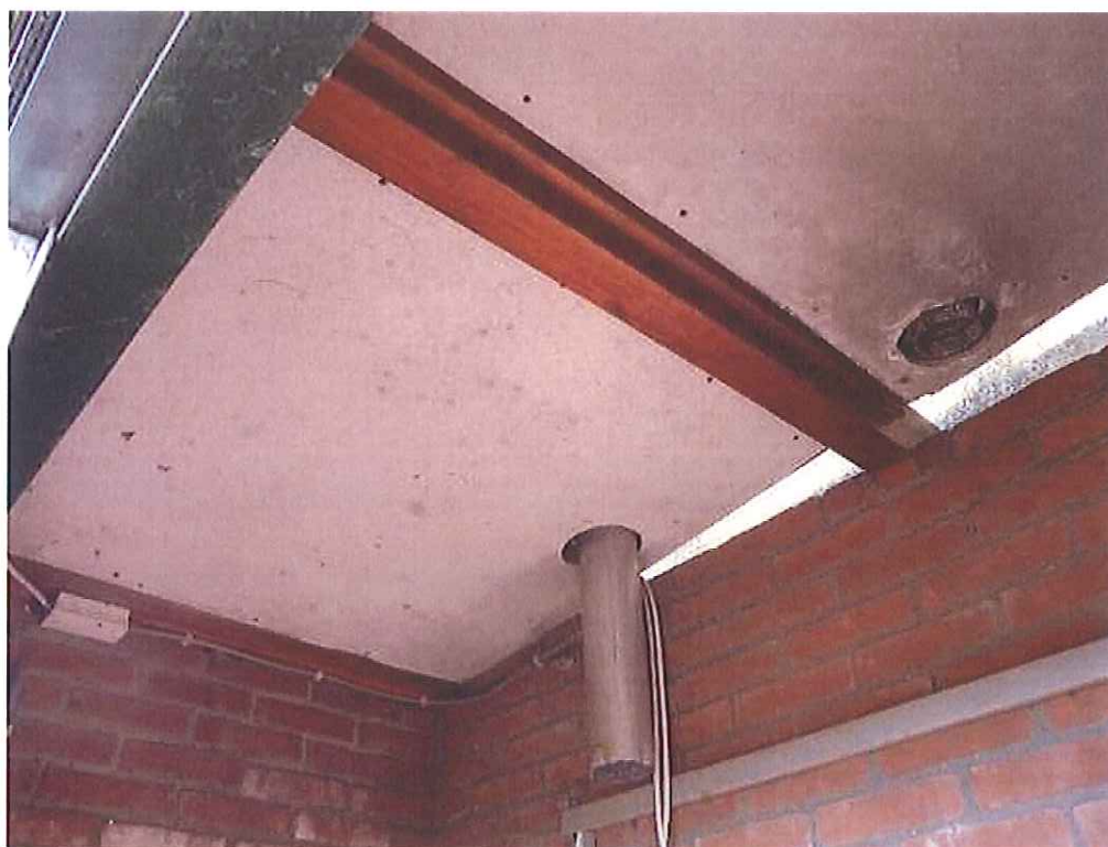
Foto 4 Niet asbesthoudende plafondplaten in geiser-ruimte toiletgebouw 2 (M04)
