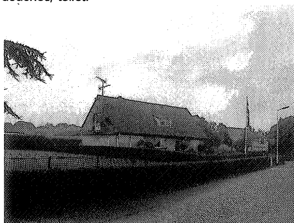
Foto 6: gemaakt vanuit het Zuiden, vooraanzijde en zijkant van het woonhuis eigenaar en receptie
