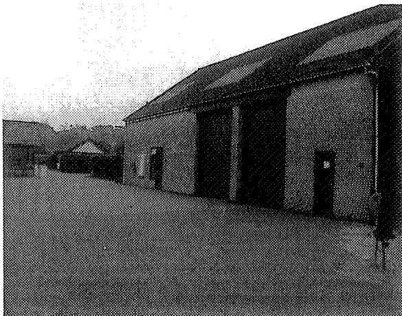
Foto 1: gemaakt vanuit het Zuid- Westen, vooraanzijde van de schuur waarin een bovengrondse tank staat
