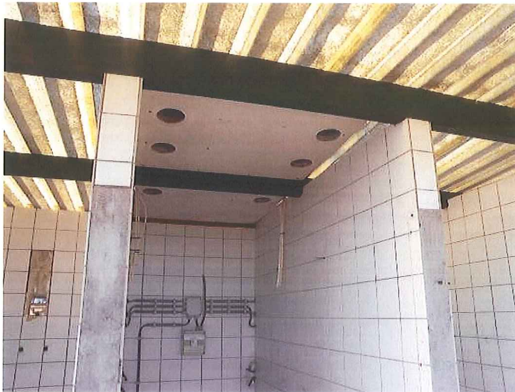
Foto 1 Niet asbesthoudende plafondplaten in cv-ruimte toiletgebouw 1 (M01)
