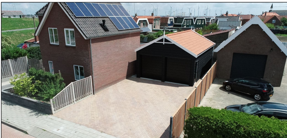
Figuur 4 Bestaande situatie plangebied
