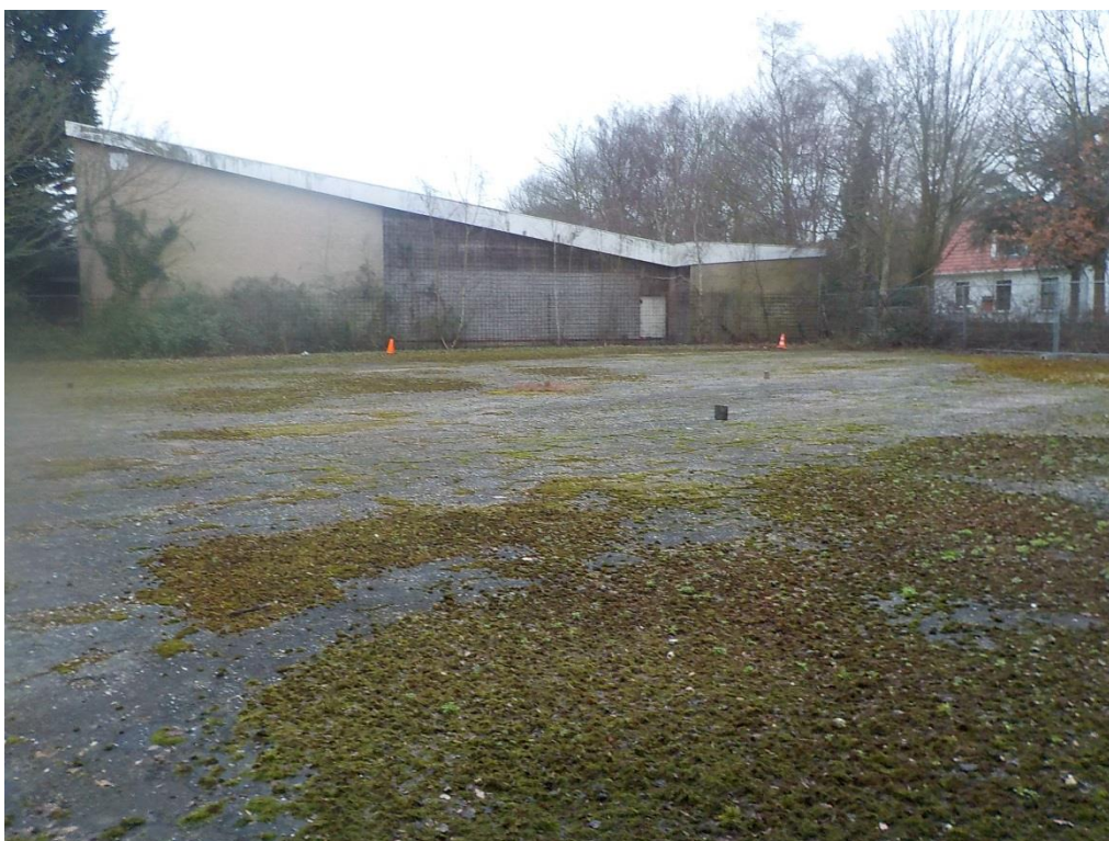
Foto 2: Achterterrein met asfaltverharding
