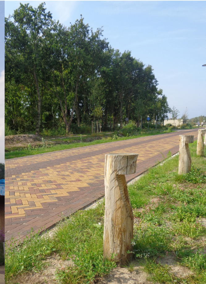
Houten bermpaaltjes, vorm en type 'Renesse', uitvoering overeenkomstig met Jan van Renesseweg, h.o.h. 3 meter
