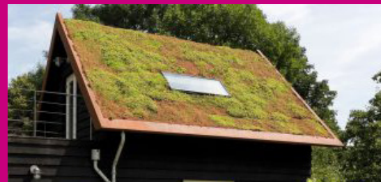
Voorbeeld groen dak
