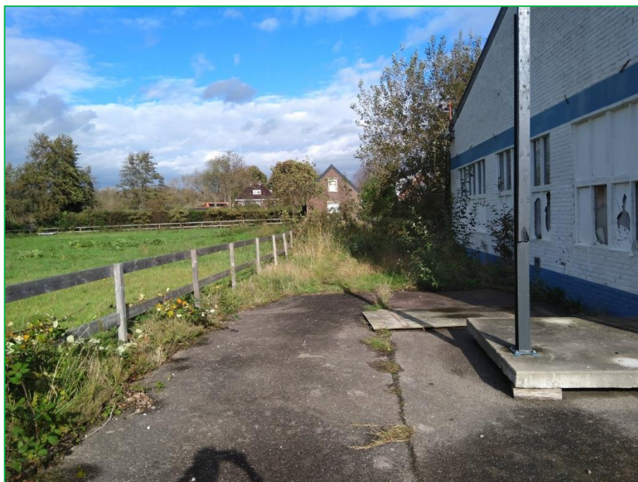
Foto 2. Achterzijde gebouw, rug naar gele container.
