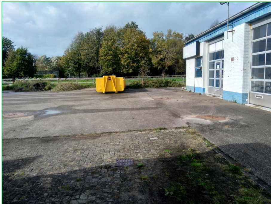
Foto 1. Asfaltverharding westzijde. Geval van ernstige bodemverontreiniging achterin tussen gele container en bebouwing
