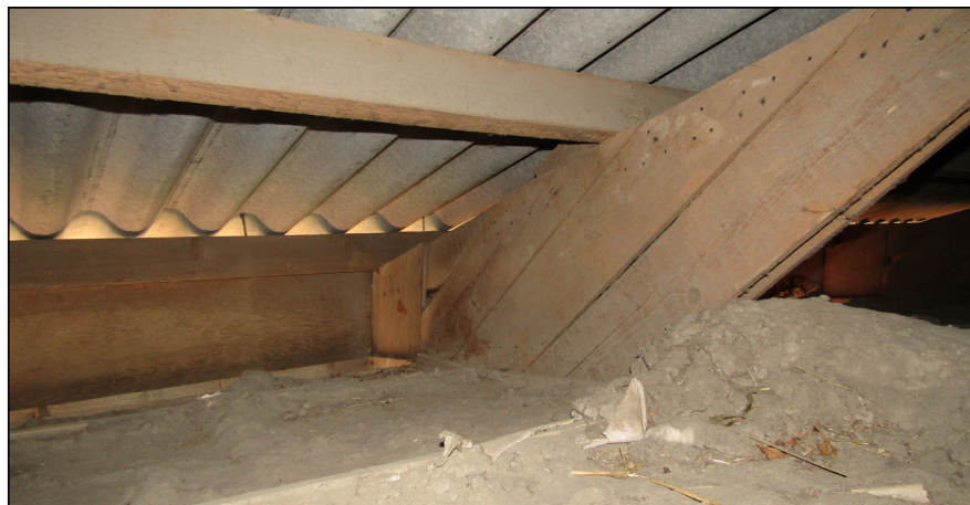
Figuur: via ventilatiegaten aan de zijkanten zijn de zolderruimte bereikbaar.
