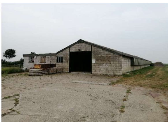
Figuur 2.2 Noordelijke pluimveestal met links daarvan het electragebouw (bron: C. Roskam)
