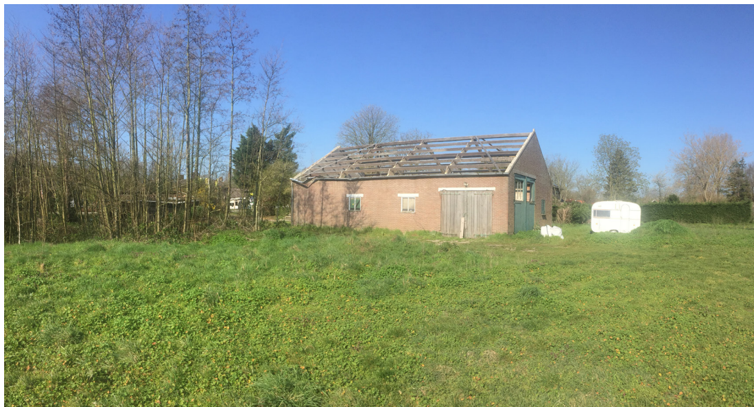
Huidige toestand terrein met loods
