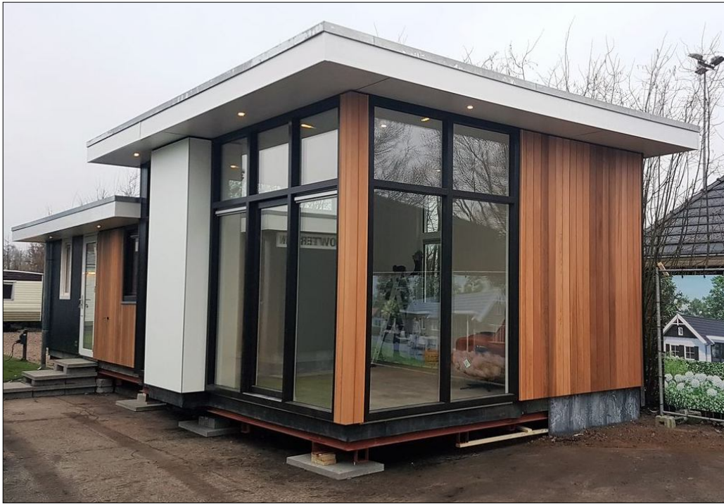
Referentie verlichting buitenzijde stacaravan/kampeerhuisje (bron: Toptotaal)
