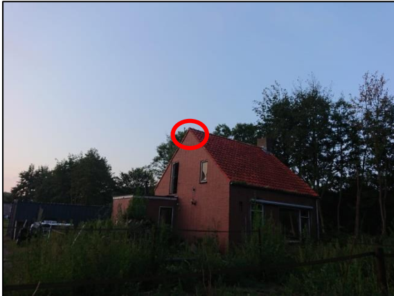
Figuur 3. Zomerverblijfplaats gewone dwergvleermuis onder nokpan noordgevel kleine woning.
