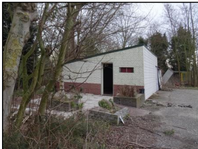
Figuur 6. Het toiletgebouw.
