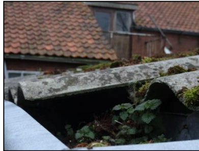
Figuur 14. Ruimte onder dakbeplating (voorgond) en dakpannen (achtergrond).
