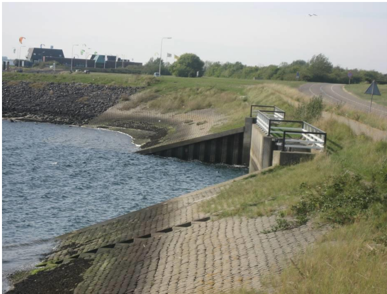
Figuur 3.3: Zicht op de in-/uitlaat van de Flakkeese Spuisluis (de Krammerzijde) met op de achtergrond het (weg)restaurant Grevelingen. Het talud is bedekt met gras en basaltblokken.
