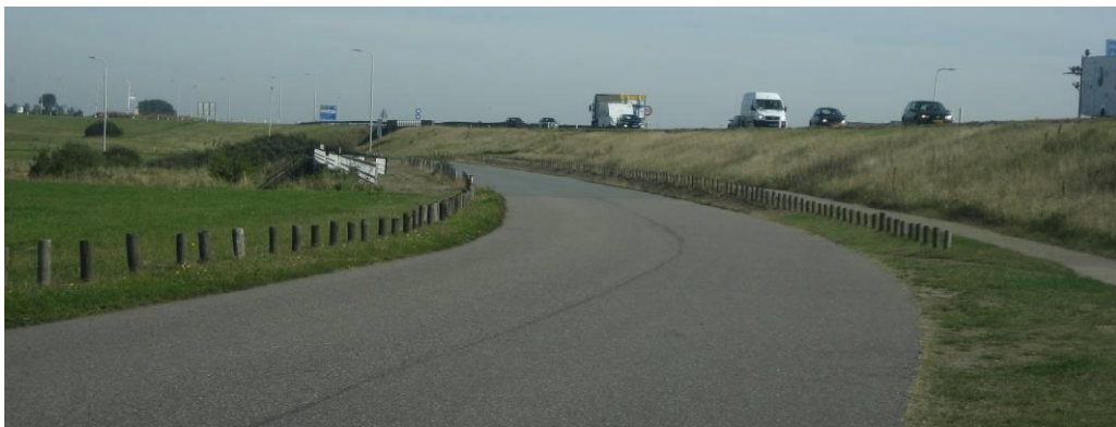
Figuur 3.2: Zicht op de N59 vanaf één van de parallelwegen. Het talud van de N59 is begroeid met gras.
