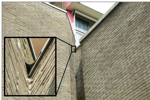
Afbeelding 5.1 | Hoek met afstaand loodslabje waaronder uitwerpselen van vleermuizen werden gevonden (inzet: afstaand loodslabje bovenin de hoek).
