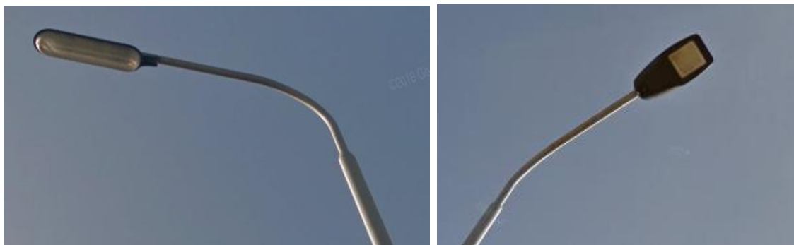
Afbeelding 4.1 Huidige straatverlichting natriumlampen (links) en LED-verlichting (rechts)
