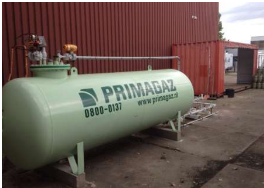
Foto 8: Propaantank met bijbehorende vulstation.
