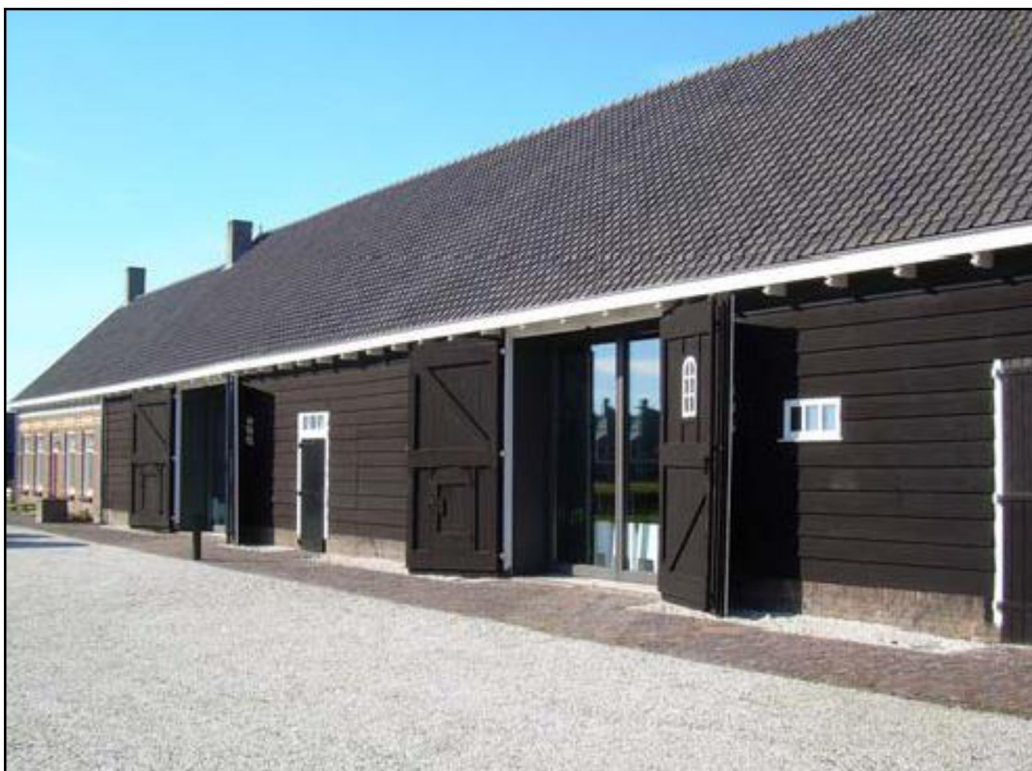
Referentiebeeld Borselse raadzaal met erfverharding van grind met een plint van baksteen langs de gevel.
