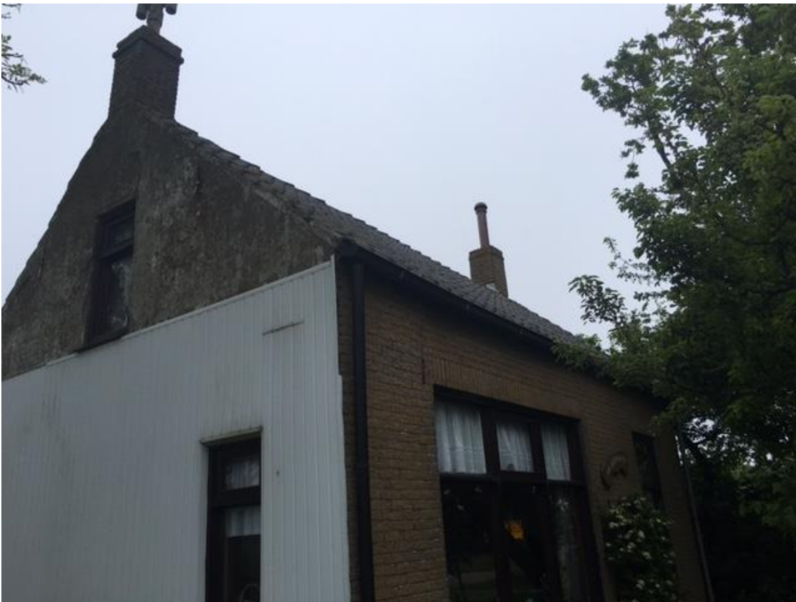
Figuur 3 beplating aan gevelzijde woonhuis
