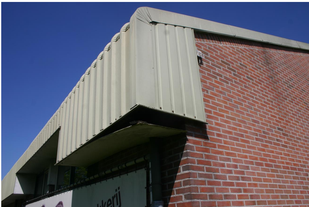
Figuur 4.5.1. Via deze kier kunnen vleermuizen het gebouw van de bakkerij in.
