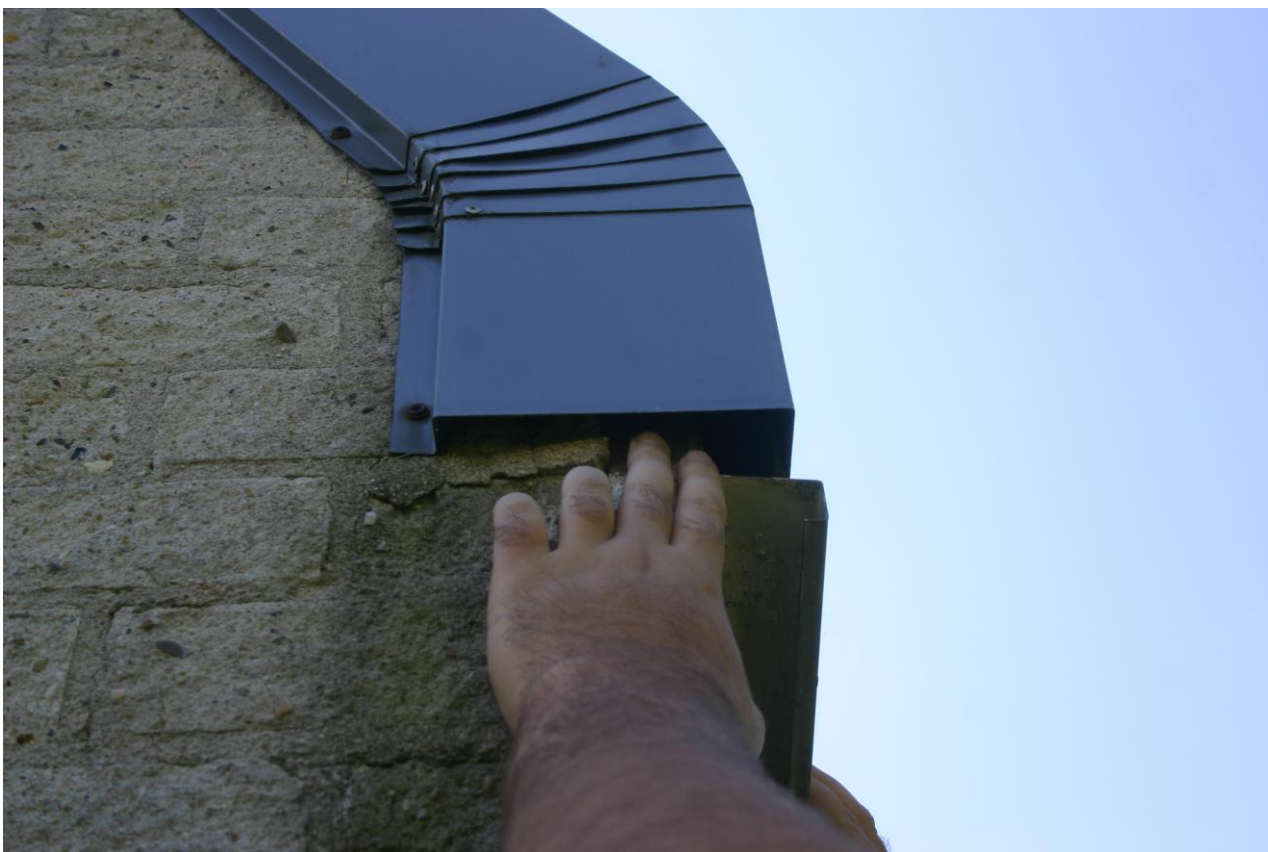
Figuur 4.5.2. Via deze kier kunnen vleermuizen het gebouw van de fietsenoutlet in.
