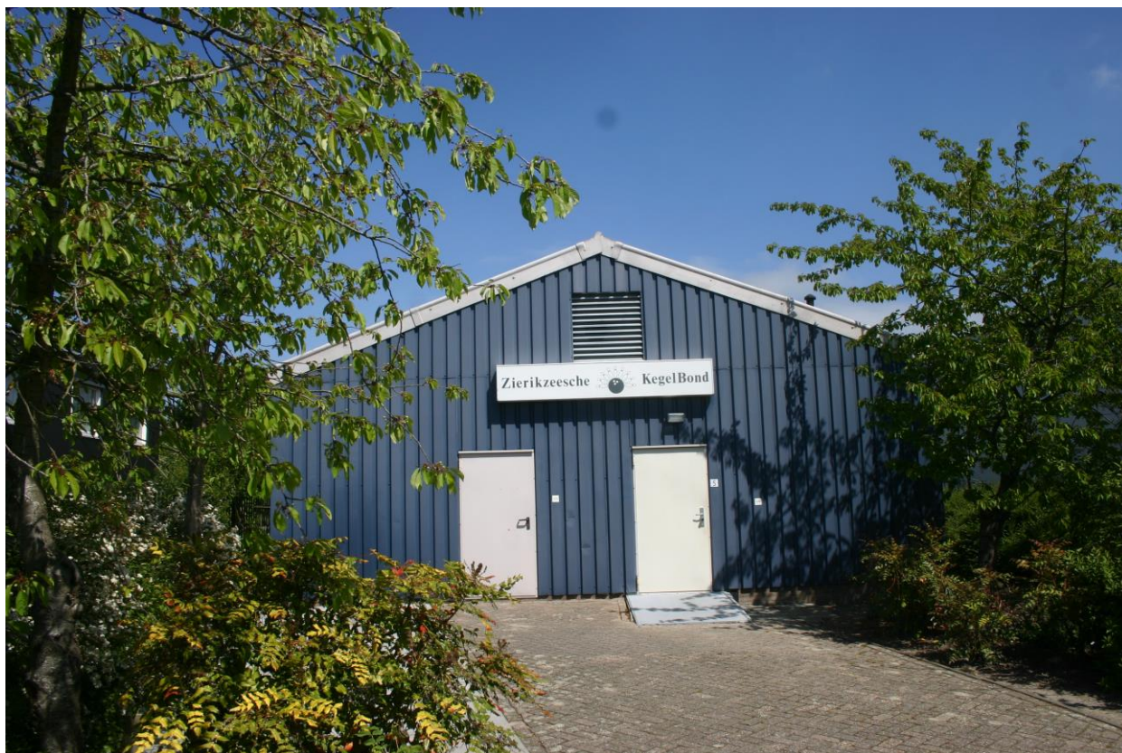
Figuur 4.1.6. Deze golfstalen loods heeft geen openingen die geschikt zijn voor dieren.
