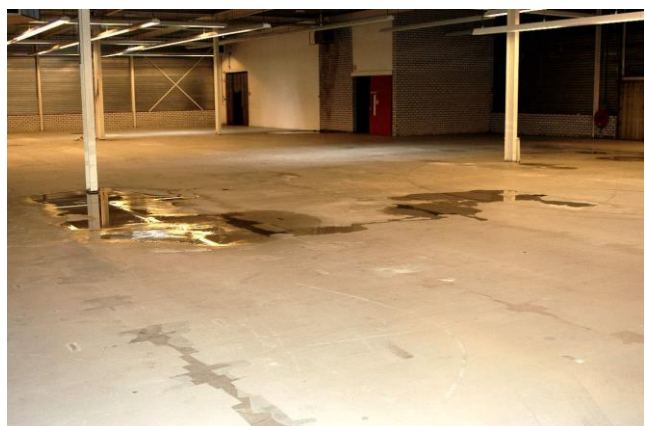
Afbeelding 5: pand aan de binnenzijde
