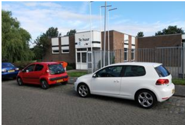
Afbeelding 11: voormalig distributiecentrum TPG
