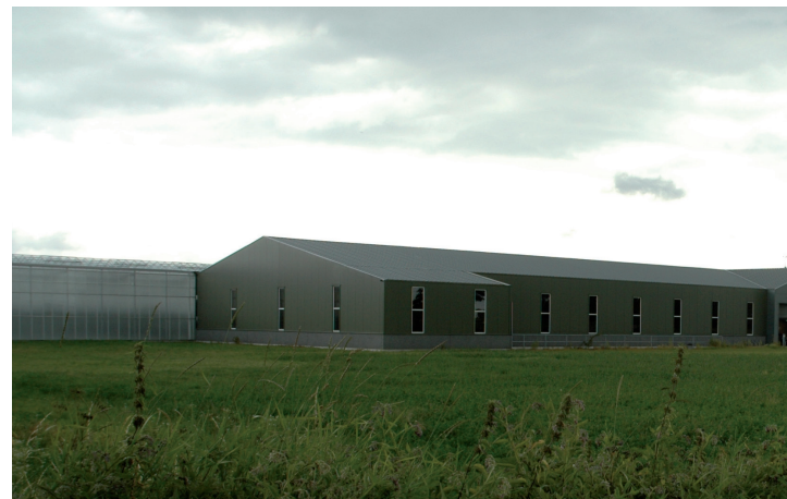
complex in huidige situatie
