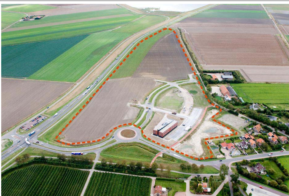
Figuur 14: Luchtfoto bestaande situatie
