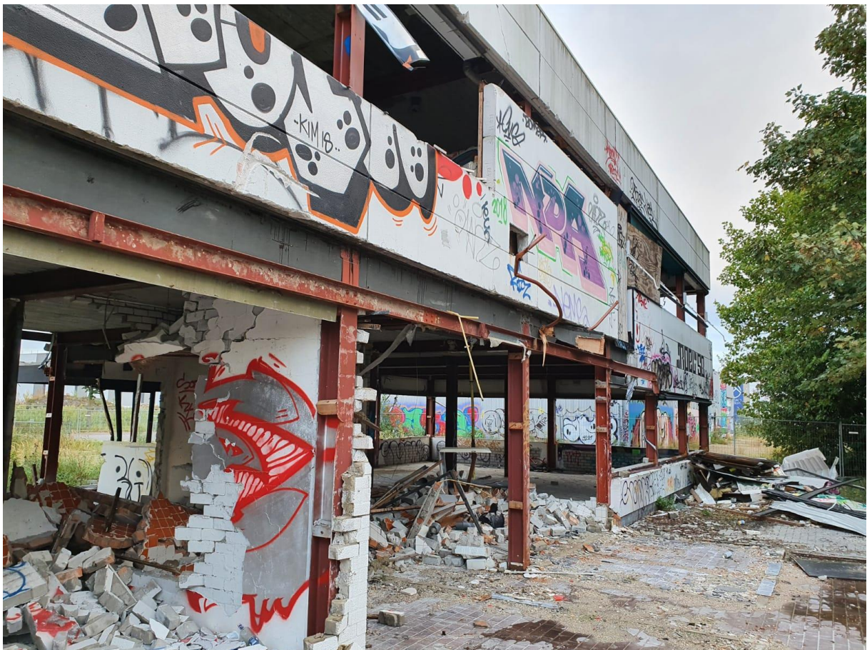
Afbeelding 6: Verwijderde ramen, deuren en muren
