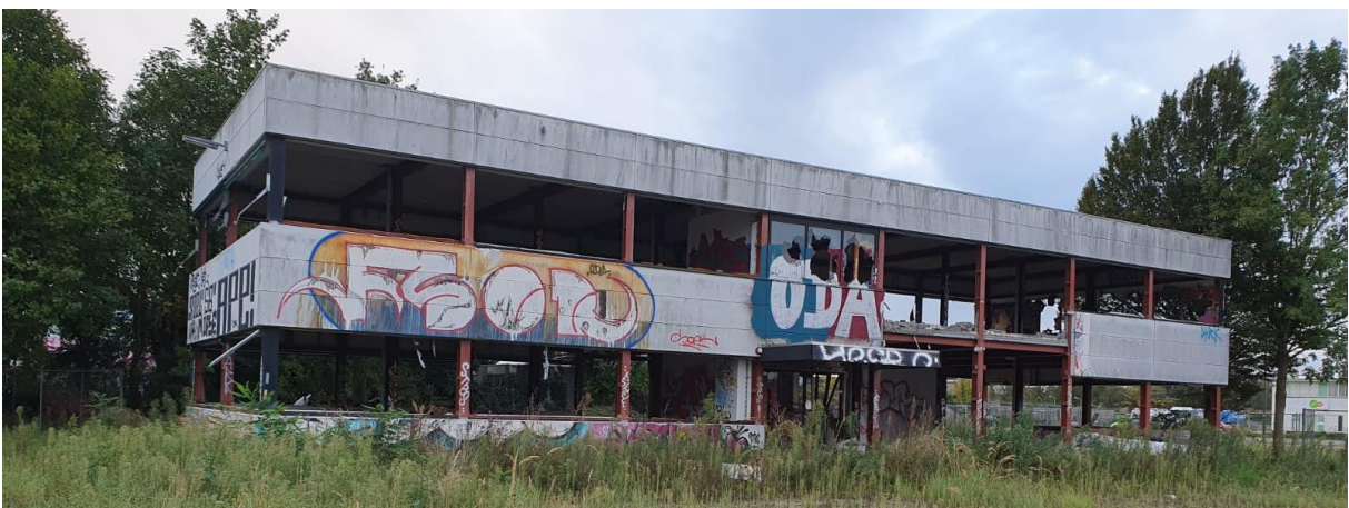
Afbeelding 2: Noordzijde van het pand aan de Borchwerf 2, dat onderdeel uitmaakt van de vliegroute van de gewone dwergvleermuis.
