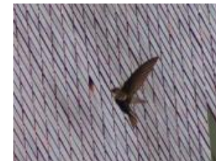
Gierzwaluwsteen weggewerkt in gevel
