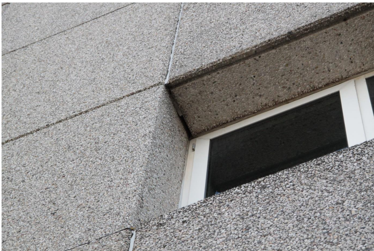
Figuur 16: Tussen de gevelstenen van het postgebouw zitten kieren waar vleermuizen tussen kunnen kruipen.
