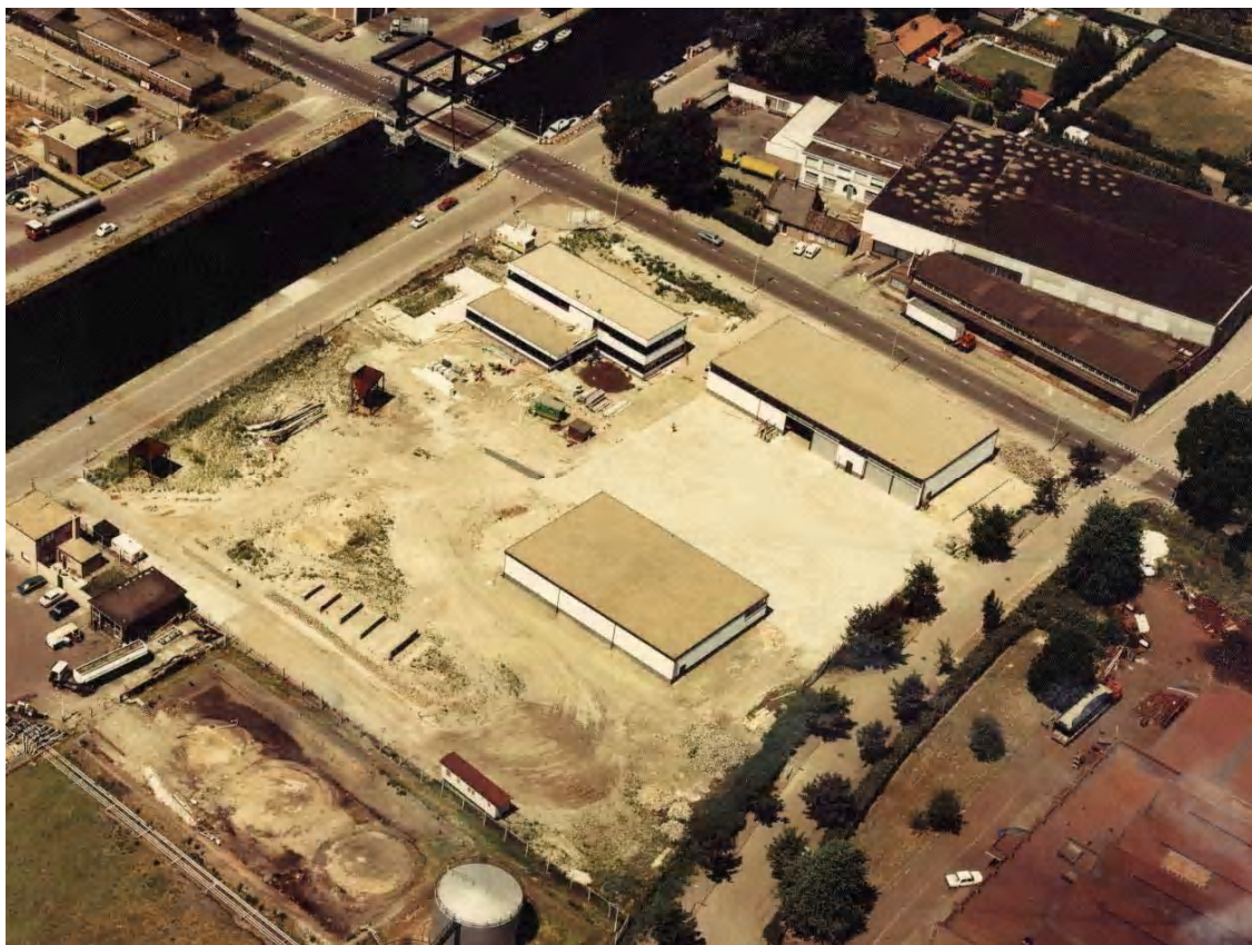
Foto 1: Nieuwbouw fa. Holland in de oksel van de Bosstraat (later Borchwerf) en de Oostelijke havendijk. De brug over de Roosendaalse Vliet is gerealiseerd. Jaartal foto: 1976. Foto is noordwest gericht.
