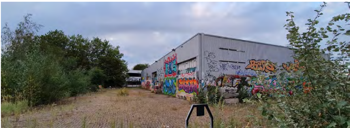
Afbeelding 1: Zuidzijde van het pand aan de Borchwerf 2a, dat onderdeel uitmaakt van de vliegroute van de gewone dwergvleermuis.
