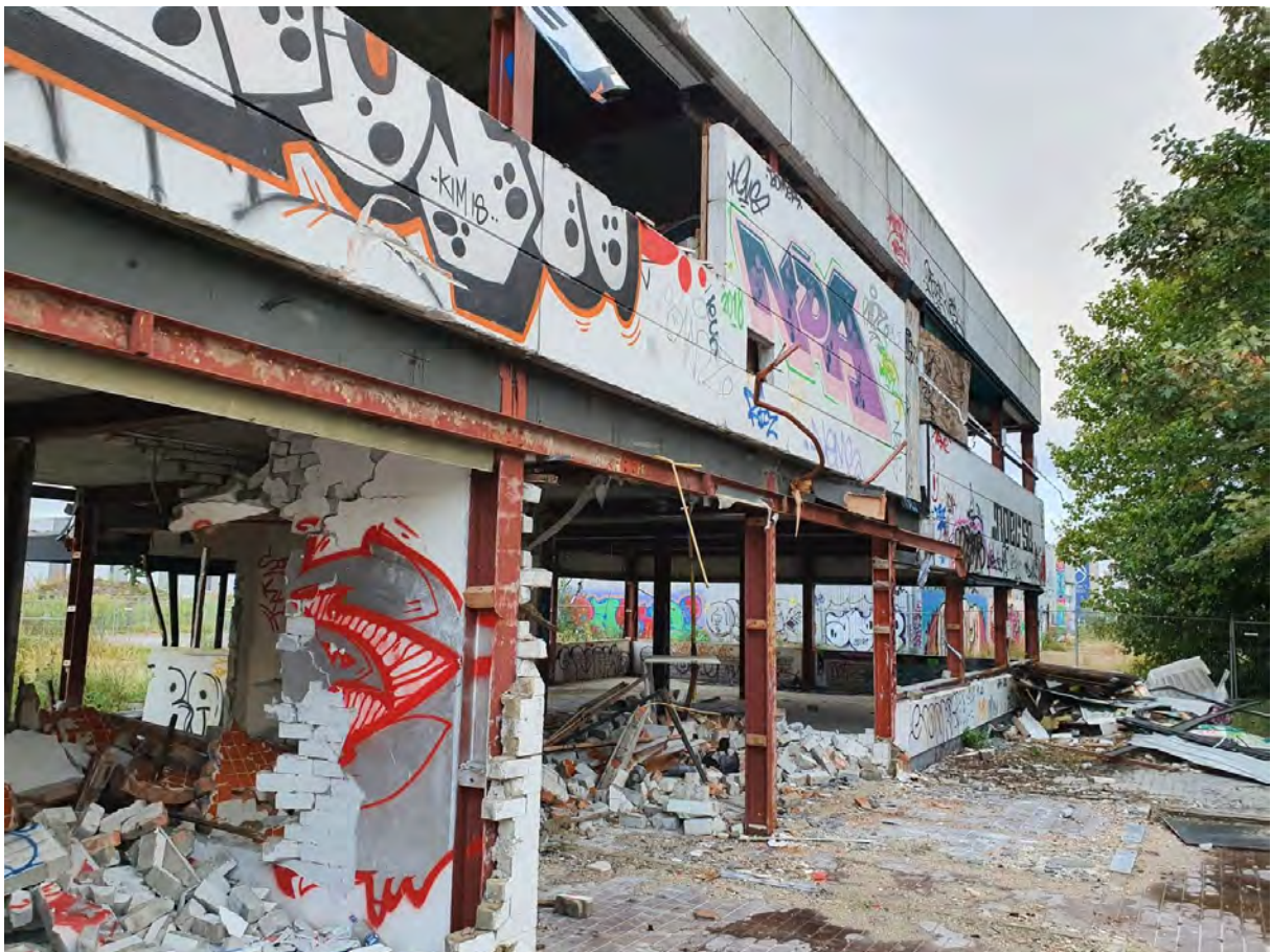
Afbeelding 6: Verwijderde ramen, deuren en muren
