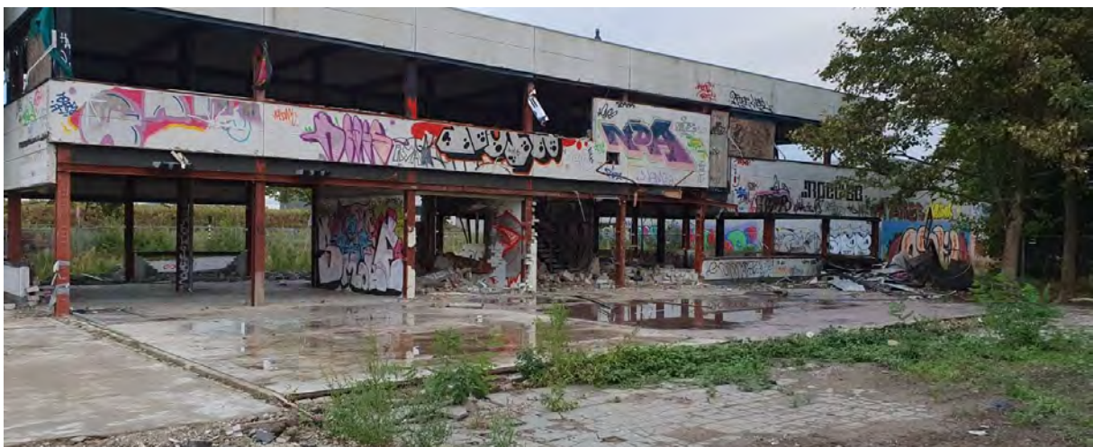
Afbeelding 2: Fundering van het bakstenen gedeelte aan de Borchwerf 2
