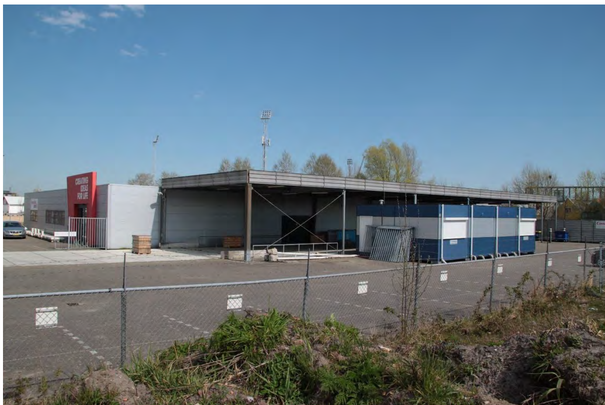
Figuur 11: Het gebouw van het Innovitapark, met plat dak, aan de industriestraat.
