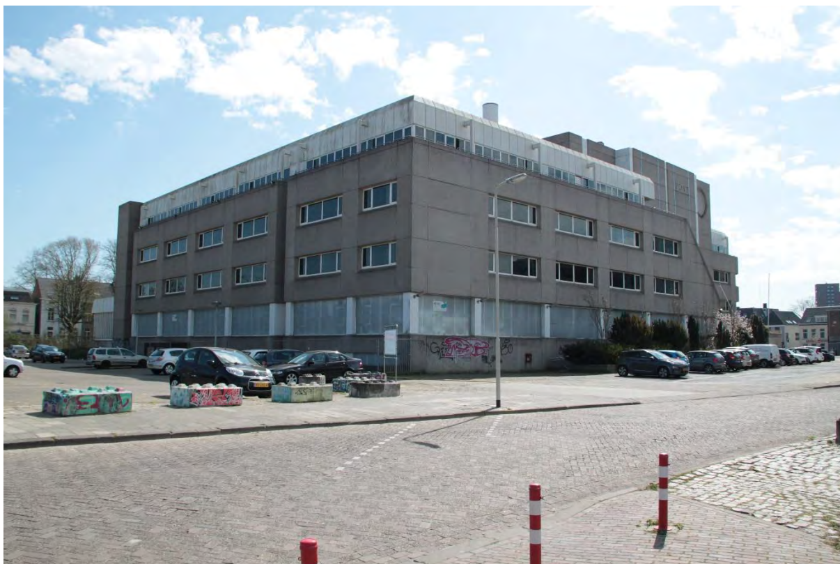
Figuur 15: Het EKP-gebouw waarvan de buitenkant wordt gerenoveerd.
