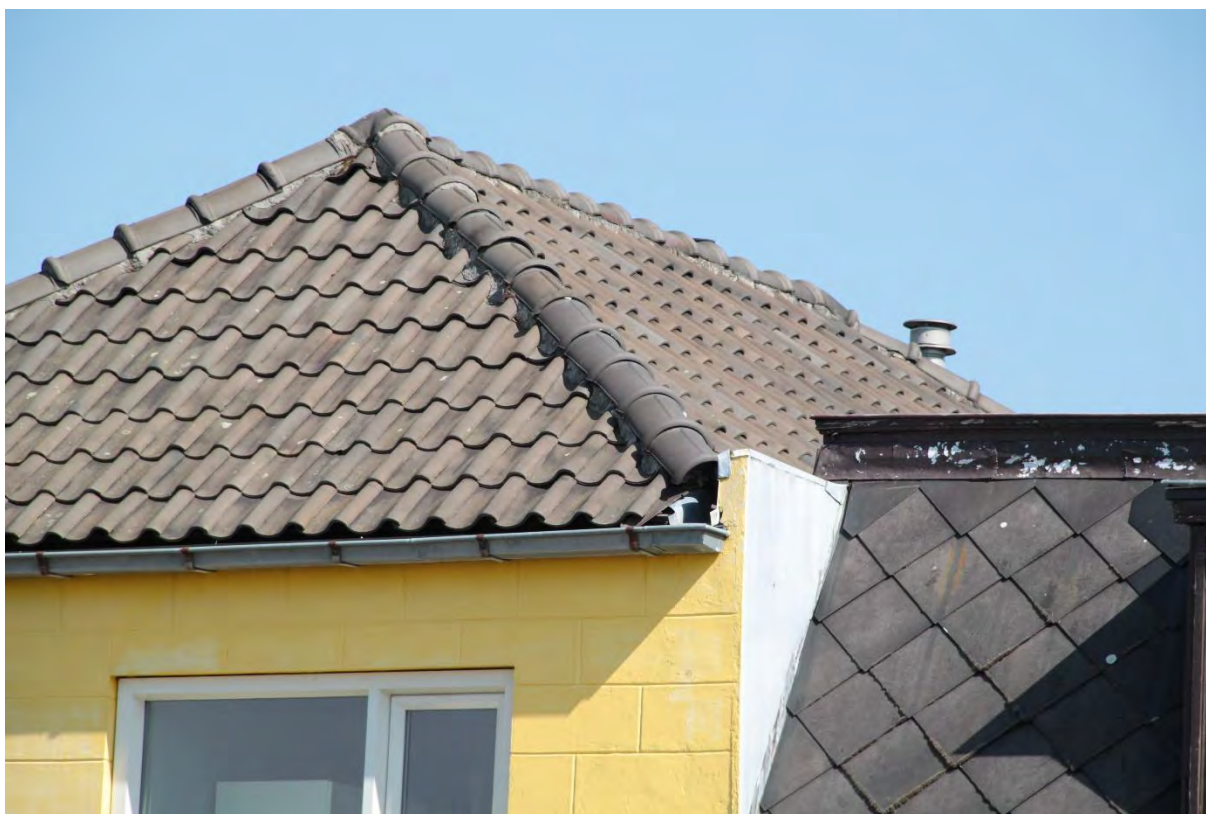
Figuur 5: Het dak van een van de woningen met zowel ruimte onder als tussen de dakpannen.
