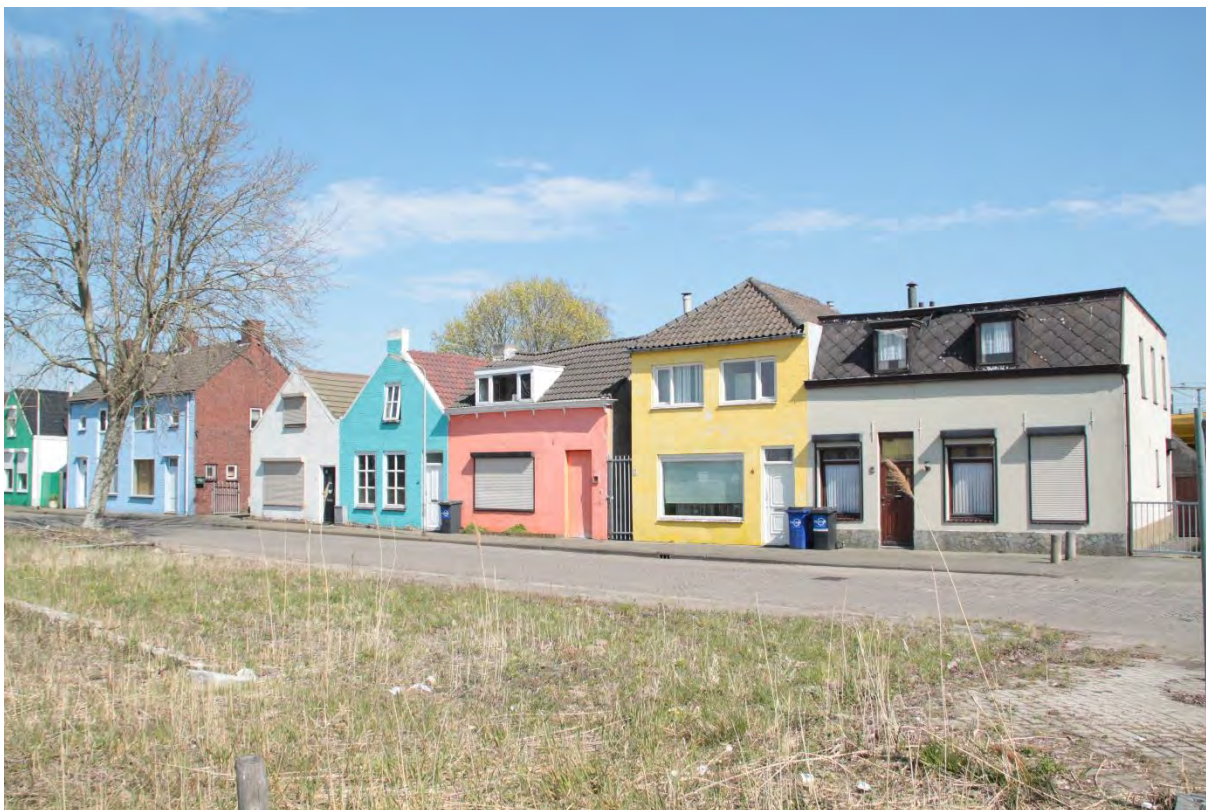
Figuur 4: Enkele woningen aan de industriestraat. Deze zijn niet allemaal bewoond.
