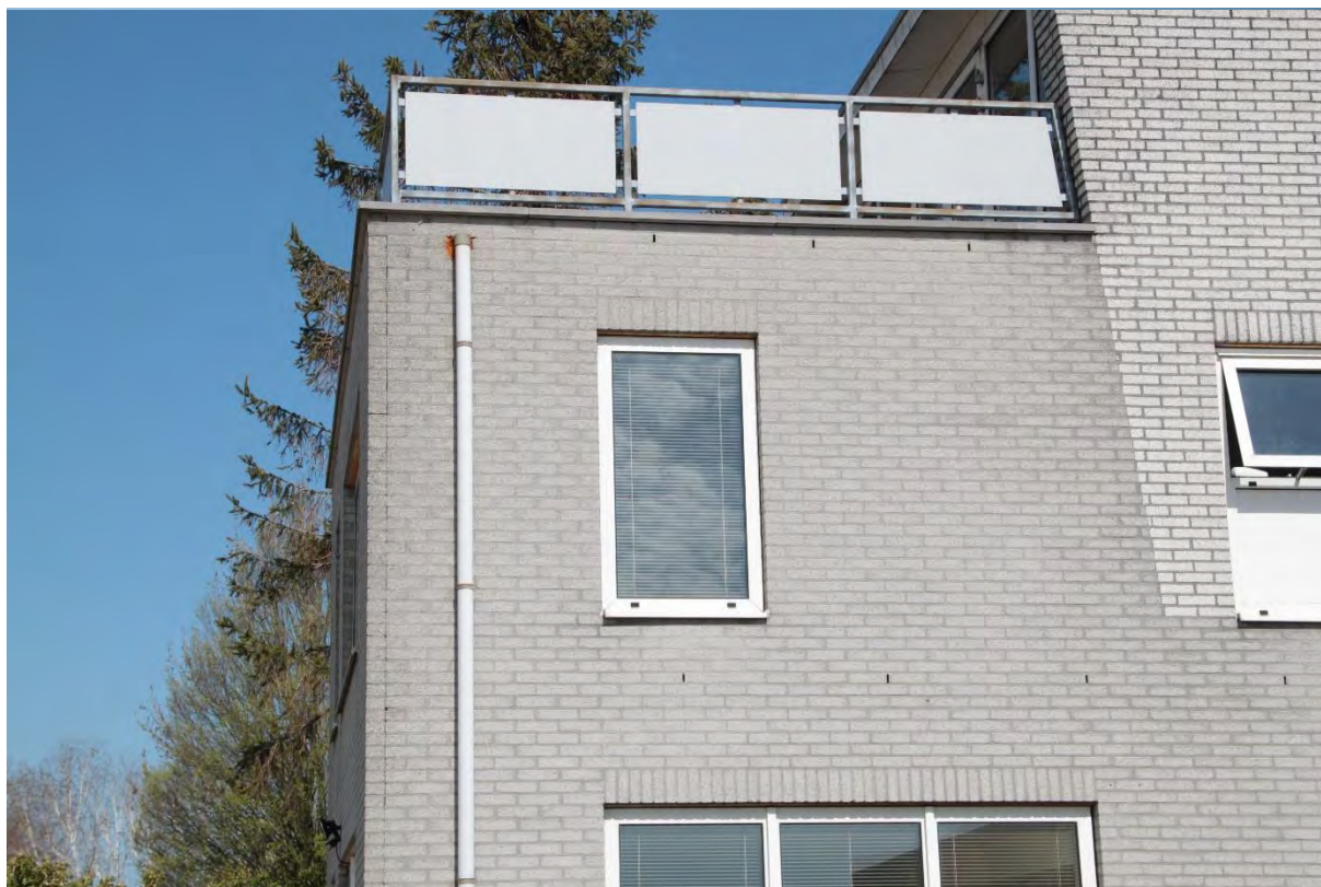
Figuur 7: Woning aan de Oostelijke havendijk met open stootvoegen in de muur, welke toegankelijk zijn voor vleermuizen.
