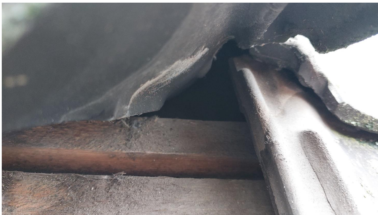
Figuur 4.4.1 Onder de onderste rij dakpannen is geen vogelschroot aanwezig; de ruimtes onder de onderste dakpannen zijn daarom geïnspecteerd maar vogelnesten zijn afwezig.
