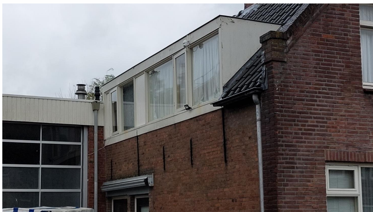
Figuur 4.4.2. De zuidgevel van de woning.
