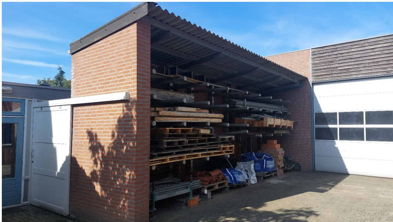
Figuur 4.4.2. De opslagoverkapping is geheel enkelwandig.
