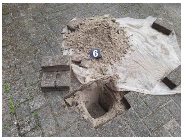
Asbestinspectiegat 6
