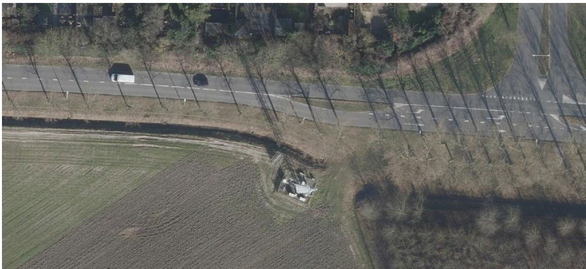
Luchtfoto zend-/ ontvangstinstallatie
