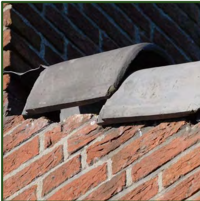
Afbeelding: ruimte tussen en onder dakpan
