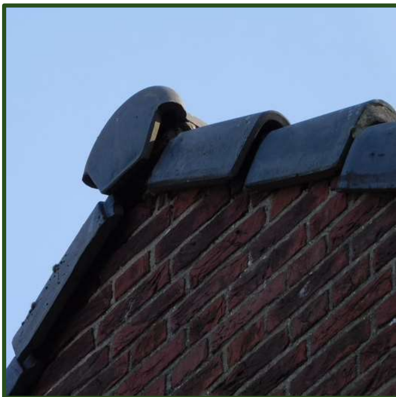
Afbeelding : Overstek van nok en de zijgevelpannen
