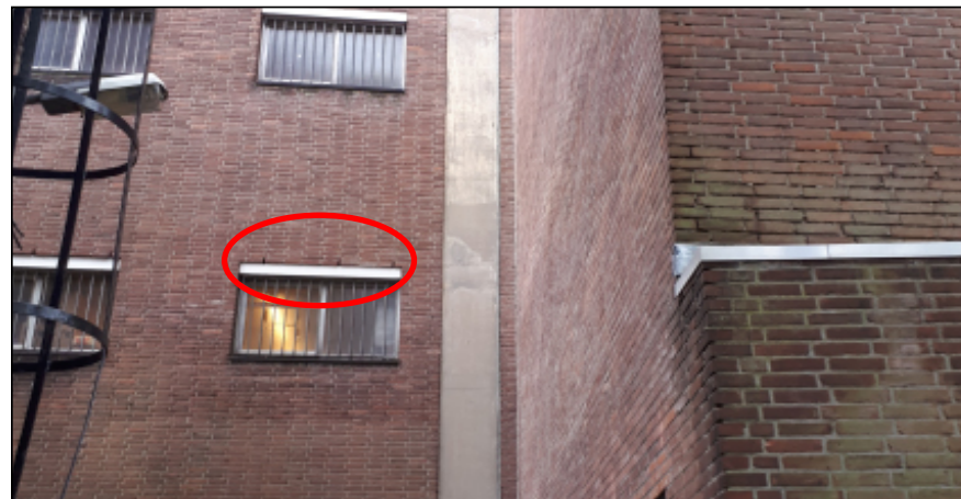
Figuur: aangeleverde foto (5 september 2019) van de noordgevel (kijkrichting zuid). Het gebouw ten oosten (links) van het plangebied heeft open stootvoegen waardoor vleermuizen verblijfplaatsen kunnen hebben in de spouw.
