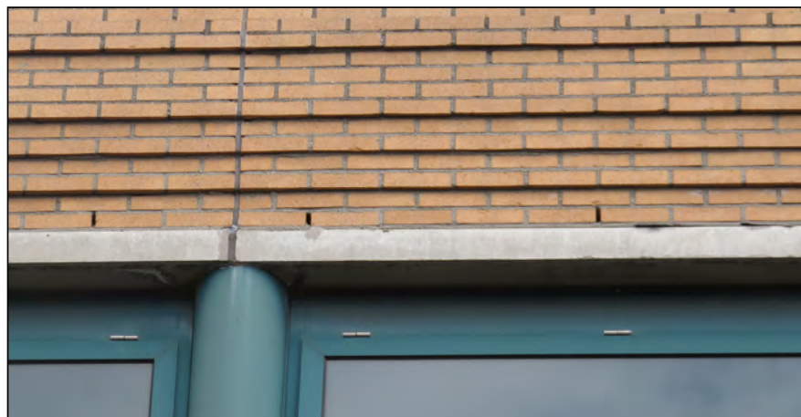
Figuur: op de zuidwestgevel zijn open stootvoegen aanwezig. Vleermuizen kunnen verblijfplaatsen hebben in de spouwmuur. Deze open stootvoegen zijn te smal voor kraamverblijfplaatsen (< 1,5 cm).
