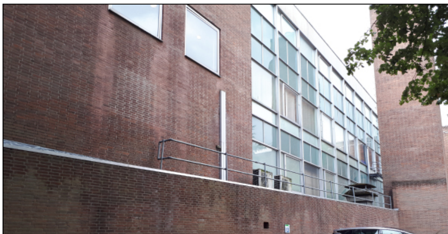
Figuur: aangeleverde foto (5 september 2019) van een deel van de noordgevel (kijkrichting zuidwest). Er zijn geen open stootvoegen aanwezig in de bakstenen muren.
