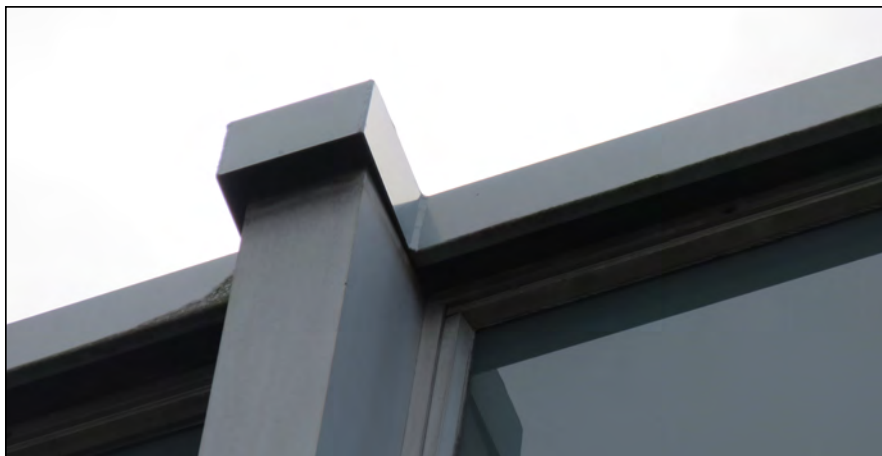
Figuur: onder de dakrand van de westgevel is ruimte aanwezig waar vleermuizen in kunnen kruipen en verblijfplaatsen kunnen hebben. De opening is groot genoeg voor kraamverblijfplaatsen ( >1,5 cm).
