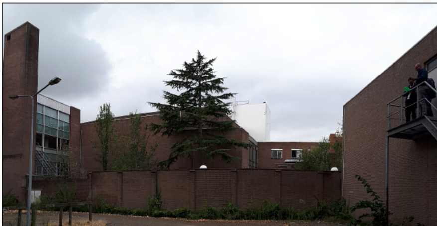
Figuur: aangeleverde foto (5 september 2019) van een deel van de noordgevel (kijkrichting noordwest). Er zijn geen open stootvoegen aanwezig, maar wel een dakrand waar vleermuizen achter kunnen kruipen en verblijfplaatsen kunnen hebben.
