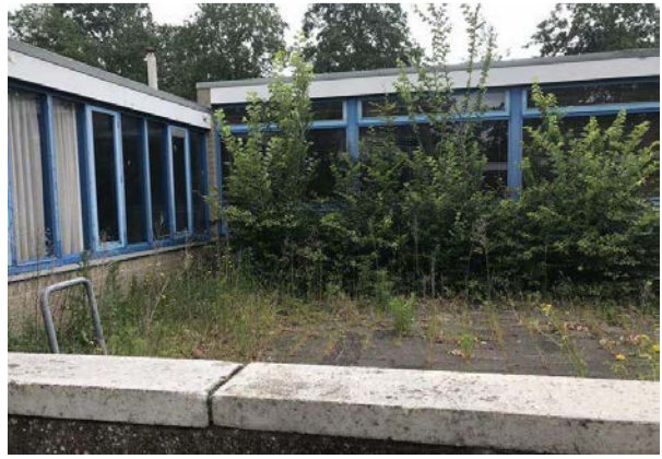
Figuur 11. Detail van het lage deel van het schoolgebouw, aanzicht vanaf de ingang van de gymzaal.
