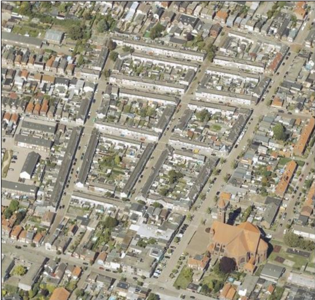
Birdsview waarbij de opzet van de wijk in een orthogonale structuur, waarbij de straten loodrecht op elkaar staan, duidelijk herkenbaar is. Bron: streetsmart, 2020.
