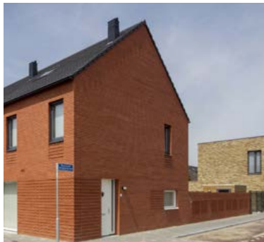
Groeseind Tilburg, Bedaux de Brouwer Architecten Mee-ontworpen erfafscheiding
