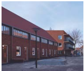
Lakerloper Eindhoven, Hans van der Heijden Architect
