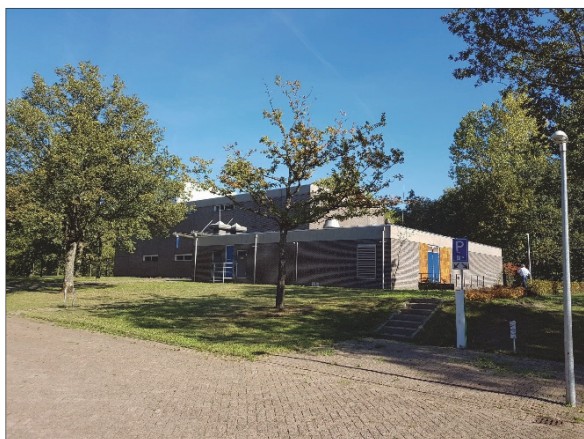
Figuur 4. Centrale te slopen gebouw
