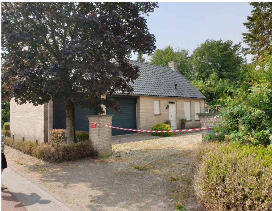
Figuur 11 - Links de dubbele garage met daarachter de voormalige zorgwoning (foto: juli 2019); blik vanuit het noordoosten; de zorgwoning wordt sinds 2018 niet meer gebruikt.
