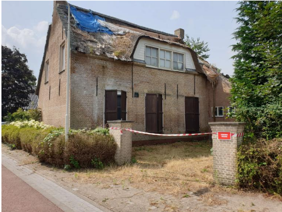
Figuur 9 - Beeld Passenberg 18 (foto: juli 2019); blik vanuit het noordoosten; het dak van de boerderij is in zeer slechte staat; daardoor treden verzakkingen en breuken op; het pand is inmiddels afgebroken.
