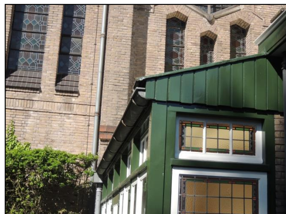
Figuur 10. Dakgoot geschikt voor huismussen aan de westkant van het klooster.
