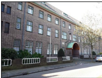
Figuur 3. Noordzijde van het klooster op de onderzoekslocatie.
