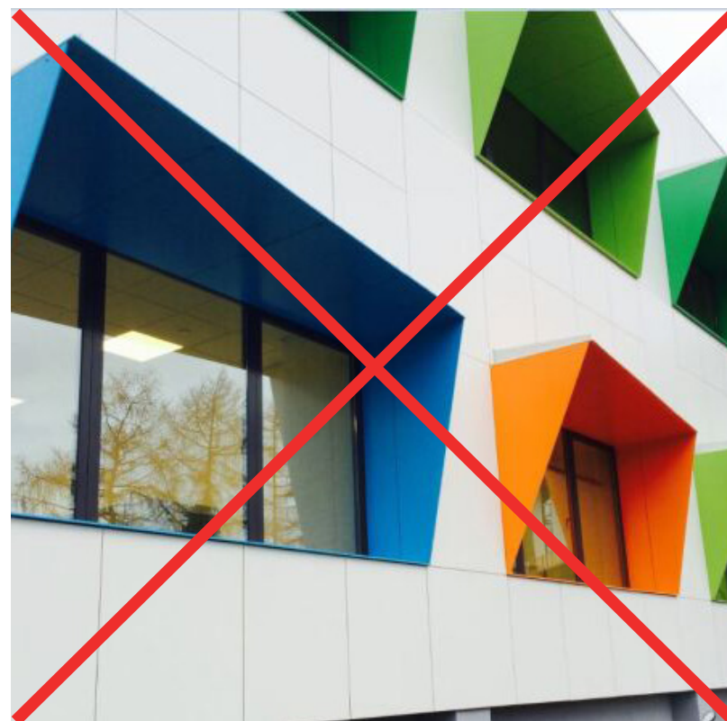
Geen plaatmateriaal en geen kleurgebruik
