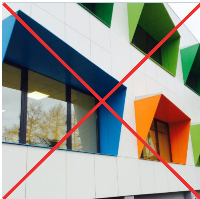
Geen plaatmateriaal en geen kleurgebruik
