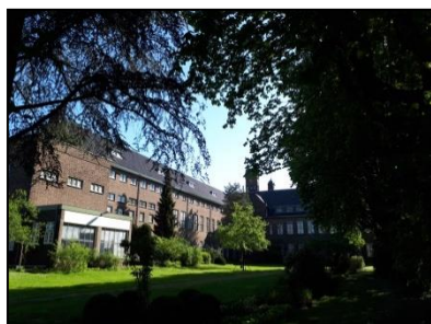
Figuur 6. Zijzicht zuidoost kant van het klooster op de onderzoekslocatie.
